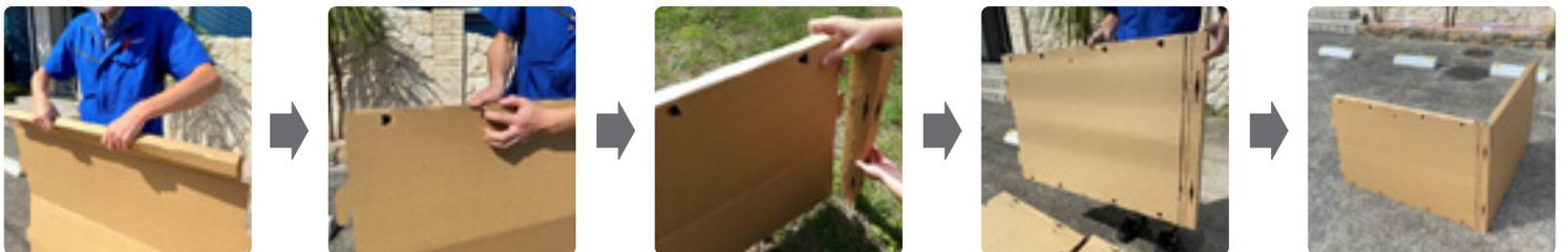
**2.** コーナーを起点に①と④のパーツを繋いでいきます。ドア開閉部に②のドア部柱を取り付け、4面組み立てたら③のジョイントを1本差し込みます。ジョイントに合わせて2段目も差し込み、ドア部分に②を取り付けます。最後にドアロックとして⑤を柱上部に取り付けて完成です。
