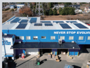
太陽光発電システム
